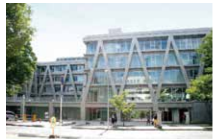
▲完成した人間・環境系教育研究棟の新棟
